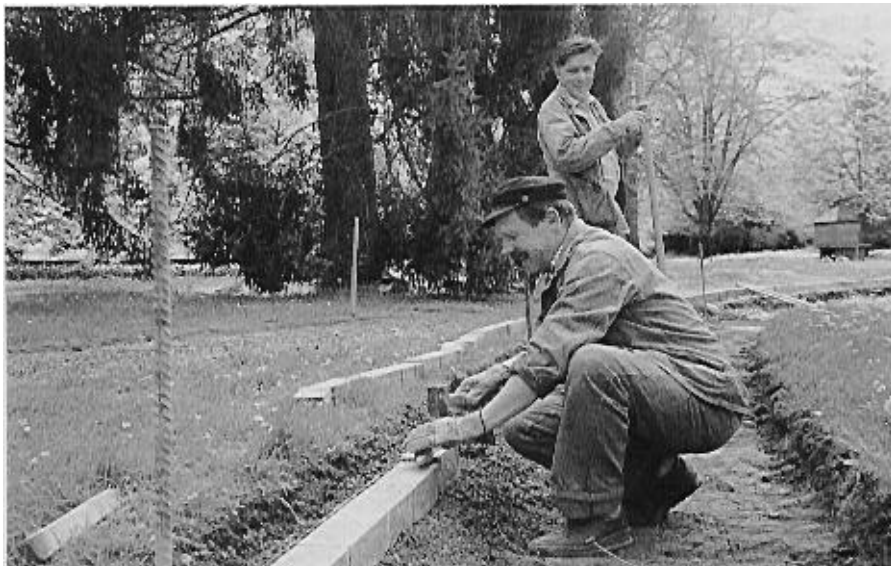
Abbildung 4: Unterbau vom Typ b)
